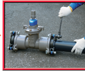
③メタルタッチするまでボルトを締め付けます。トルク管理不要。
